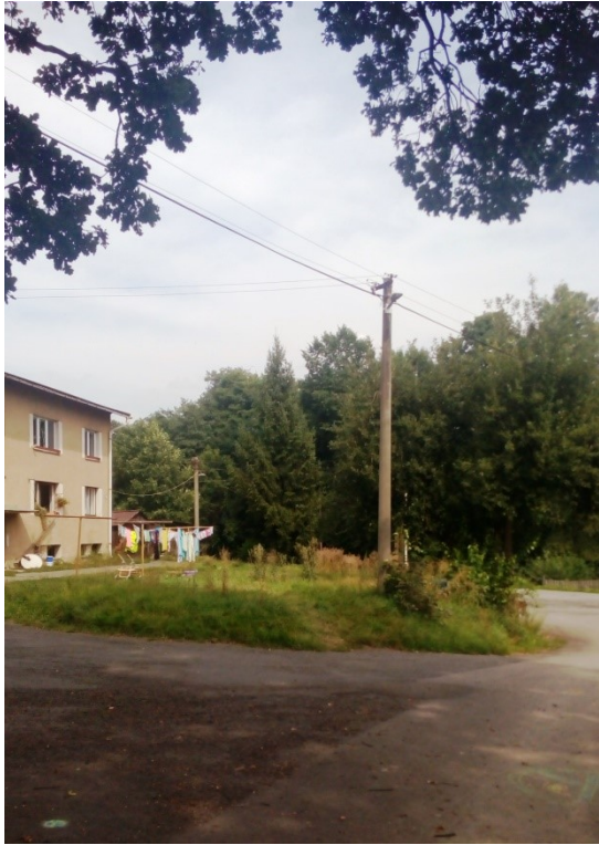
Doplňená lampa Petrašovice u bytovek
